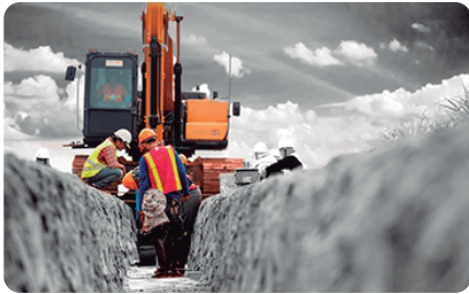
Valas e Escavações
